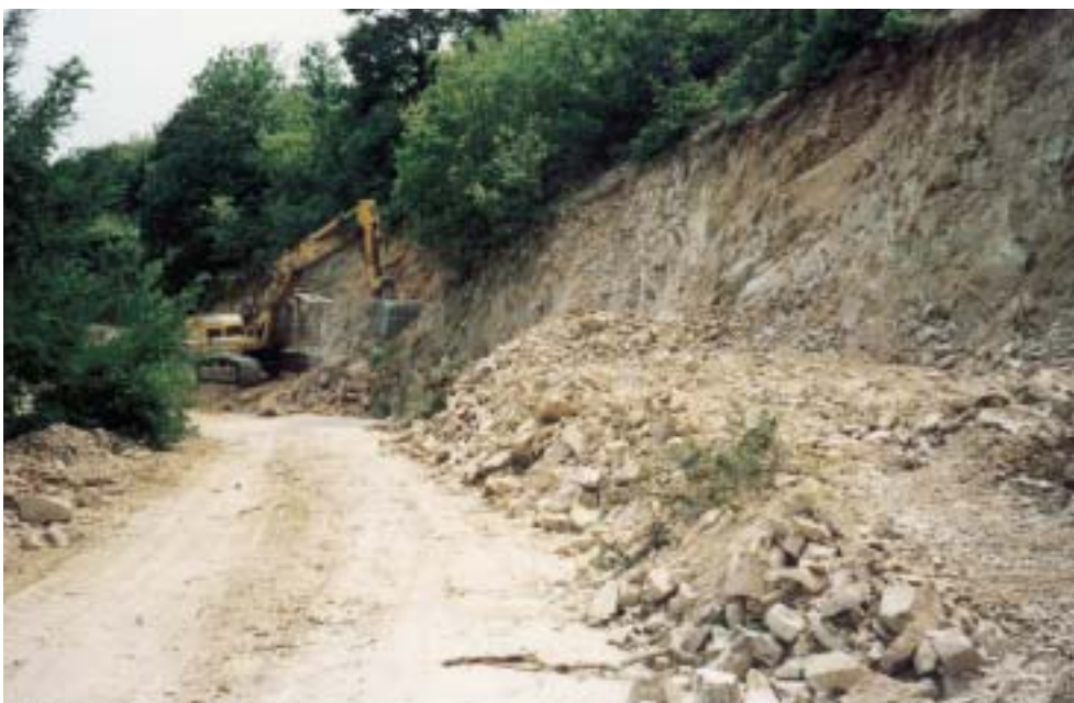
Έργα διάνοιξης οδικού δικτύου σε περιοχή του Δ. Μύκης.
