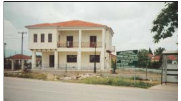
Κατασκευή Κέντρου Πολιτιστικής Κληρονομιάς στο Αβατο
