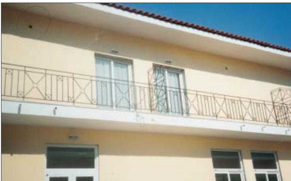
Επισκευή-αναβάθμιση ξενώνων στον οικισμό Ιαματικών Πηγών Κοιν. Θερμών
