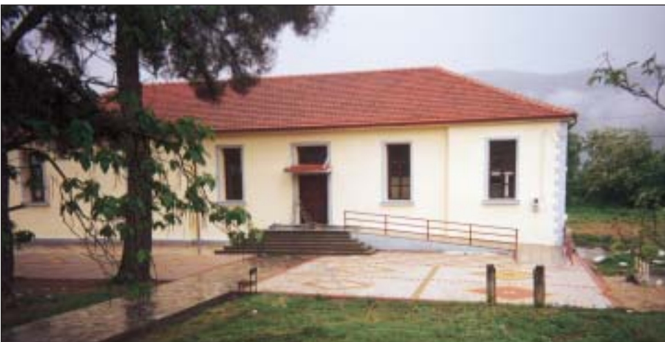
Διαμόρφωση υπάρχοντος κτιρίου σε Νηπιαγωγείο στον Δαφνώνα.
