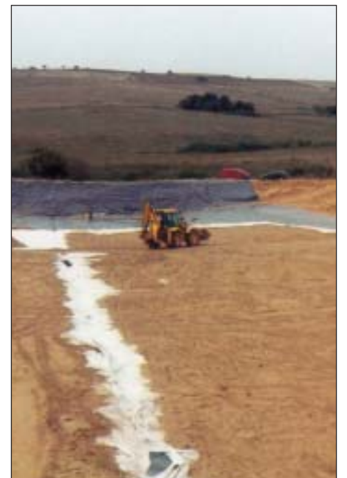
Κατασκευή λεκάνης υγειονομικής ταφής απορριμμάτων.
